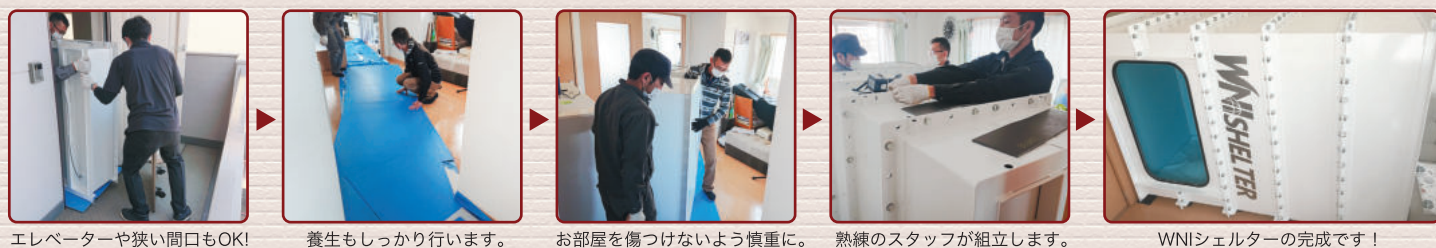
エレベーターや狭い間口もOK! 養生もしっかり行います。 お部屋を傷つけないよう慎重に。 熟練のスタッフが組立します。 WNIシェルターの完成です!
